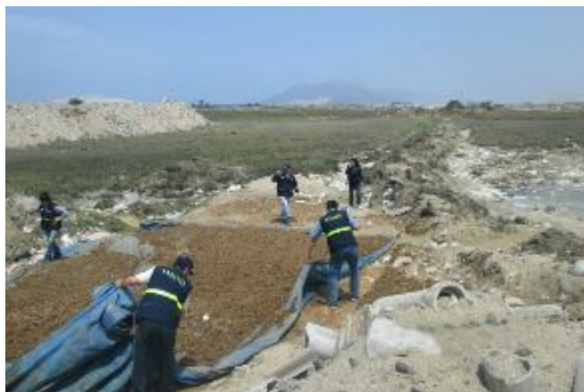
En la acción de control participaron, además, operarios de maquinaria pesada proporcionados por las municipalidades distritales de Nuevo Chimbote, Santa y Coishco.
