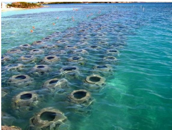
Figura N° 4.- Se aprecia cinco filas paralelas de arrecifes modulares artificiales tipo Reef Ball en una playa de México
