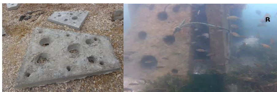
Figura N° 2.- Paneles construidos e instalado de arrecifes artificiales tipo Californiano frente a la playa Atenas, en bahía de Paracas
